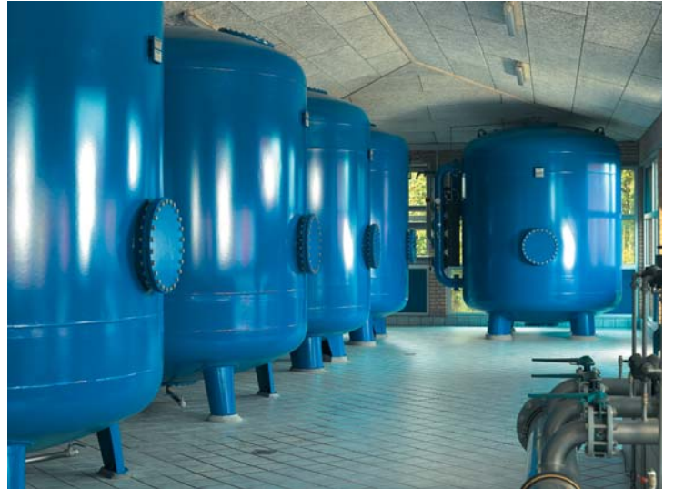
Raudan, mangaanin, ammoniumin sekä kalsiumkarbonaatin saostamisen jälkeen veteen jäävän hiilidioksidin pelkistämistä vesilaitoksessa. Laitteisto koostuu viidestä rinnakkain kytketystä, tyyppin TFB 75 laitteesta, puhaltimesta sekä huuhtelupumpusta. Virtausnopeus: 265 m 3 /h. Säiliöiden väri on asiakkaan valittavissa.
