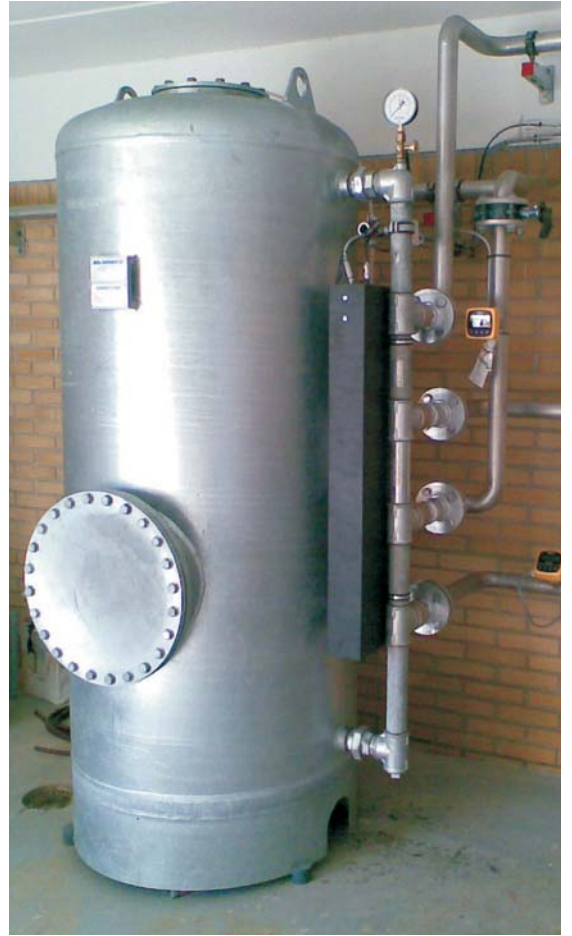
Arseenin poistaminen adsorption avulla vesilaitoksella. Ratkaisu käsittää automaattisen, tyyppiä NSB 170 olevan painesuodattimen, joka on asennettu linjaan avoimien suodattimien jälkeen. Virtausnopeus: 12 m 3 /h.
