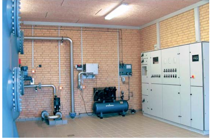
Täydellinen vedenpuhdistuslaitteisto, jossa painesuodatin sekä hapetus- ja vastavirtahuuhtelulaitteistot
