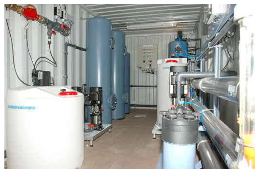
Esimerkki asiakaskohtaisesta ratkaisusta, johon kuuluvat annostelu, vedenpehennys, hiilisuodatus ja käänteisosmoosi.
